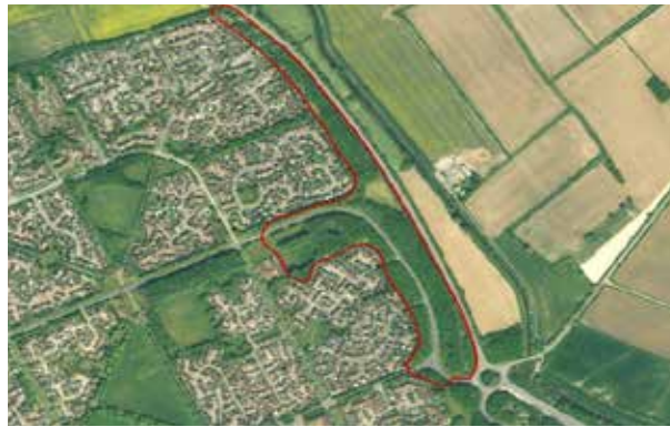
H. A15 Shelter Belt
